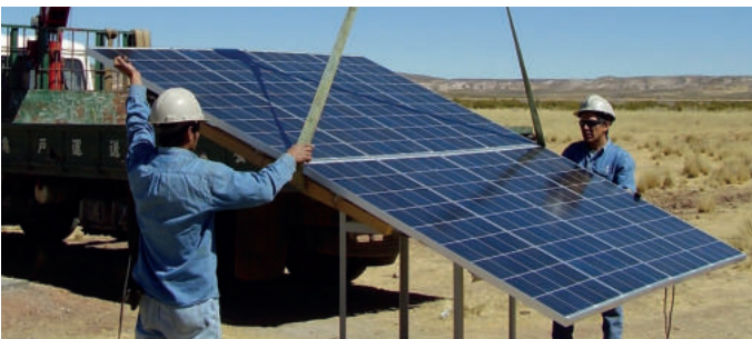
Instalación de Paneles Solares para Generación Energía Eléctrica La Paz, Desaguadero YPFB Transporte
