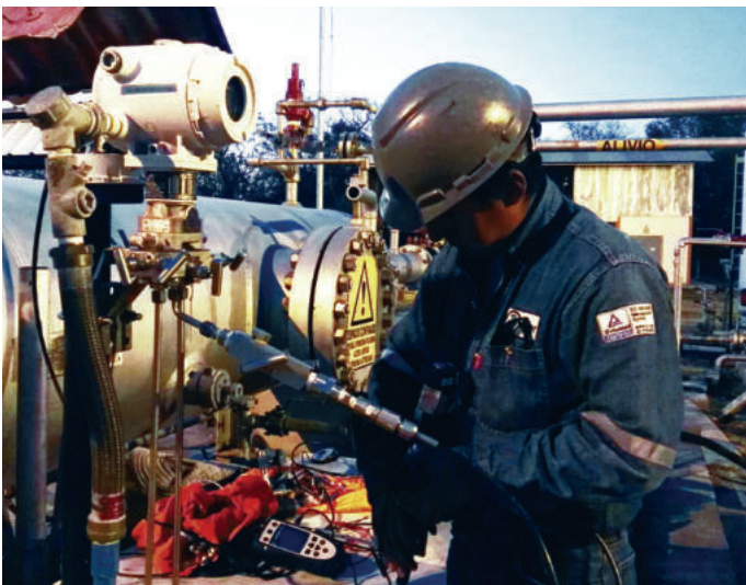
Mantenimiento Sistema de Medición de Líquidos y Gas Bateria Ñupuco Oxy-Vintage
