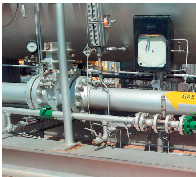
Sistema de Medición de Líquidos y Gas Planta El Porvenir (oxy-vintage)
